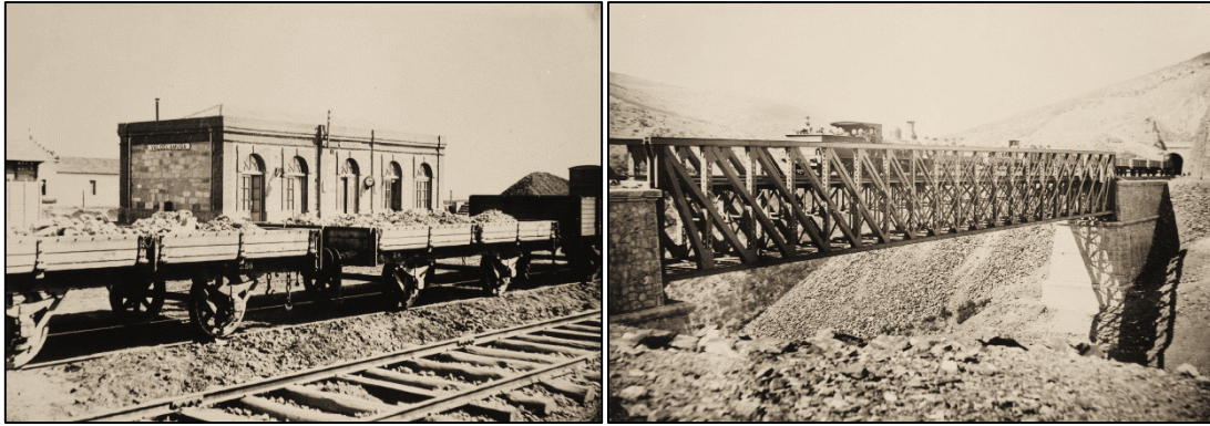
Bateas con balasto en Valdelamusa y tren de trabajo en el viaducto y túnel de Valdemoral – 1888 (fotos AHMZ)
