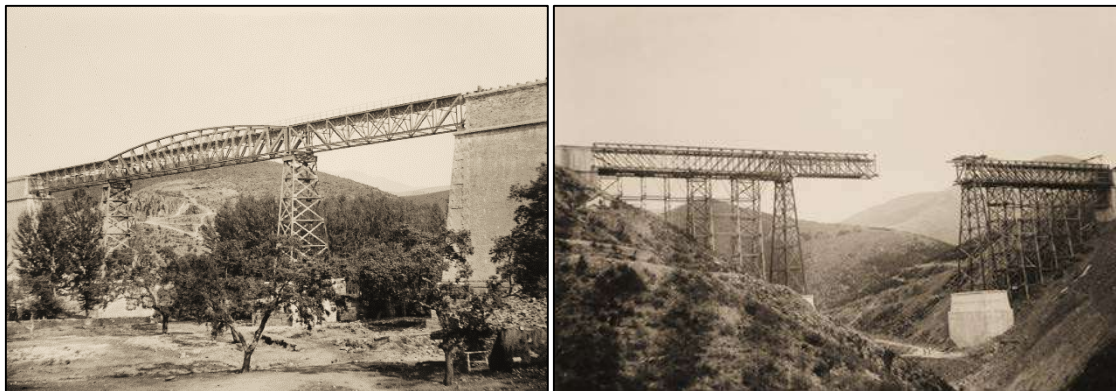
Puente sobre el Múrtiga y viaducto de Tres Fuentes en construcción – 1888 (fotos AHMZ)
