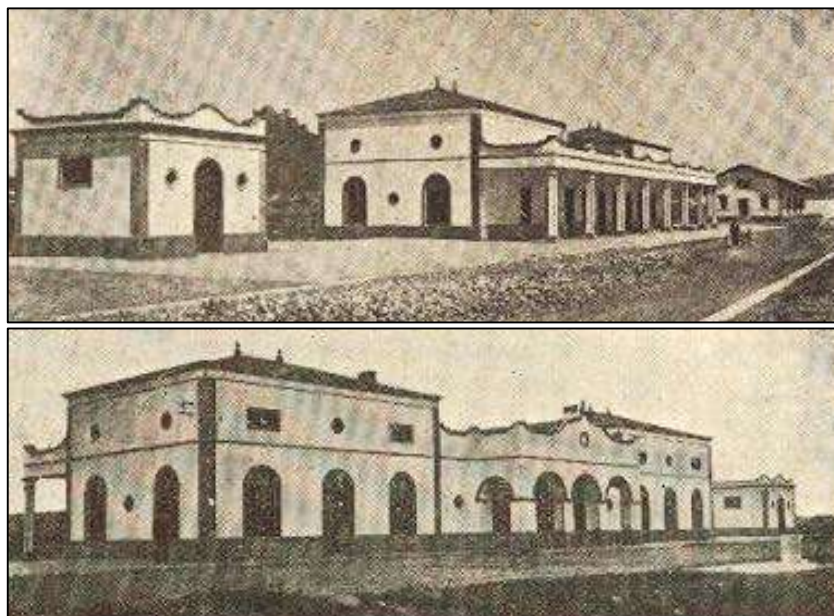
Obras del Zafra-Villanueva – 1936: Estación de Burguillos del Cerro (Gazeta dos Caminhos de Ferro)
